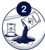
2. DESPEJE E NIVELA
